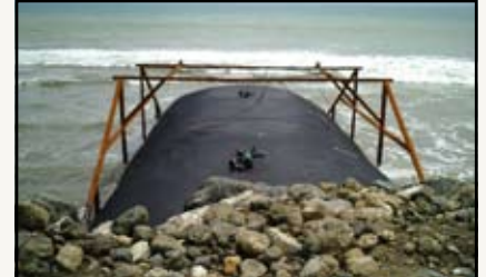
Système TenCate Geotube® maintenu en place pendant son remplissage par un cadre métallique.
