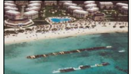
Système TenCate Geotube® installé en mer comme brise-lames.
