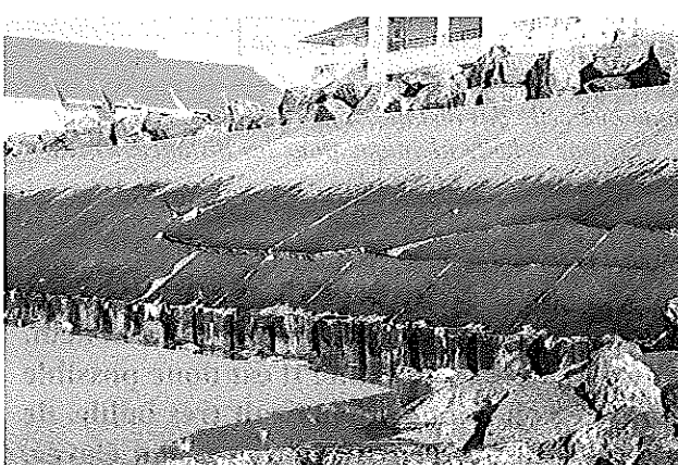
Avril 2007 : la dalle s'est encore une fois rompue de la même manière
