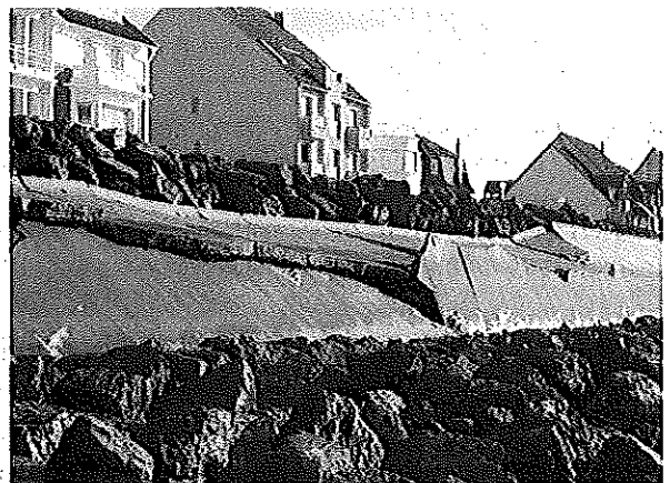
Avril 2007 : la dalle s'est encore une fois rompue de la même manière
