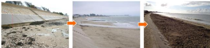
Confortement de cordon dunaire
