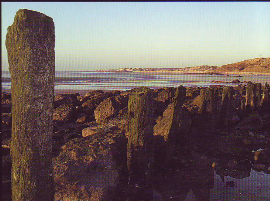
Rivage du Boulonnais, vu de la Pointe aux Oies. Au premier plan les restes de palplanches du perré Lonquéty. (cliché OL, 10 février 2006, 17 heures 16).
